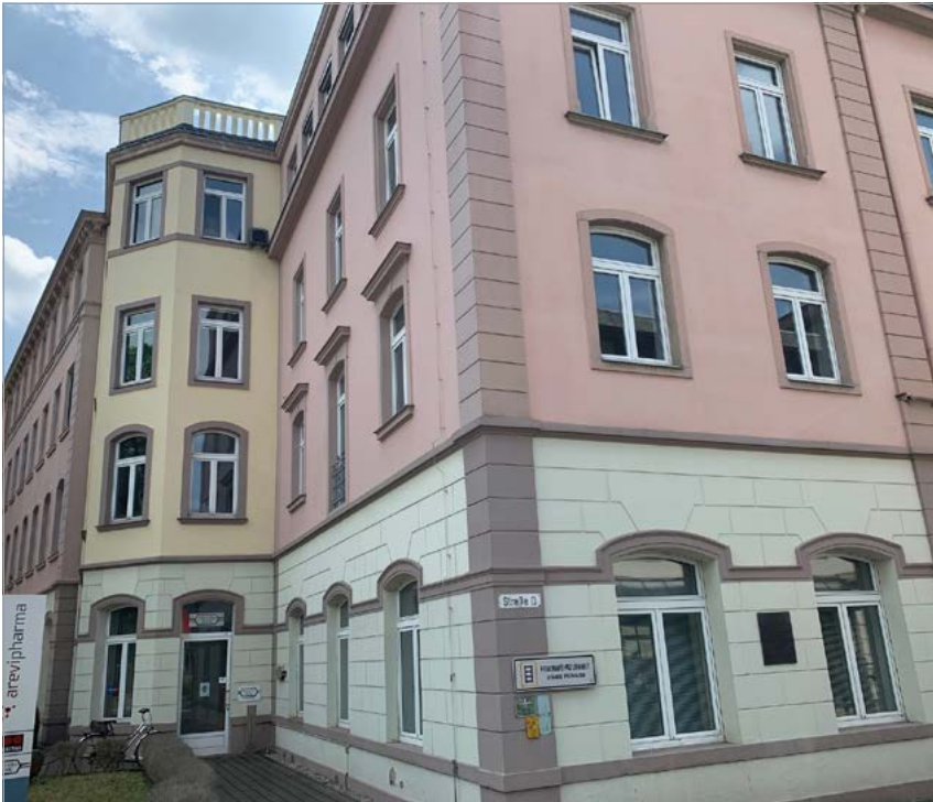
Meißner Straße 35 nahe der Stadtgrenze zu Dresden: Ehem. Chemische Fabrik von Heyden, später VEB Arzneimittelwerk Dresden. 1875 die weltweit erste pharmazeutische Produktion im industriellen Maßstab. Das Fabrikations- und Verwaltungsgebäude im Bild von 1900/1912. Heute Arevipharma.
