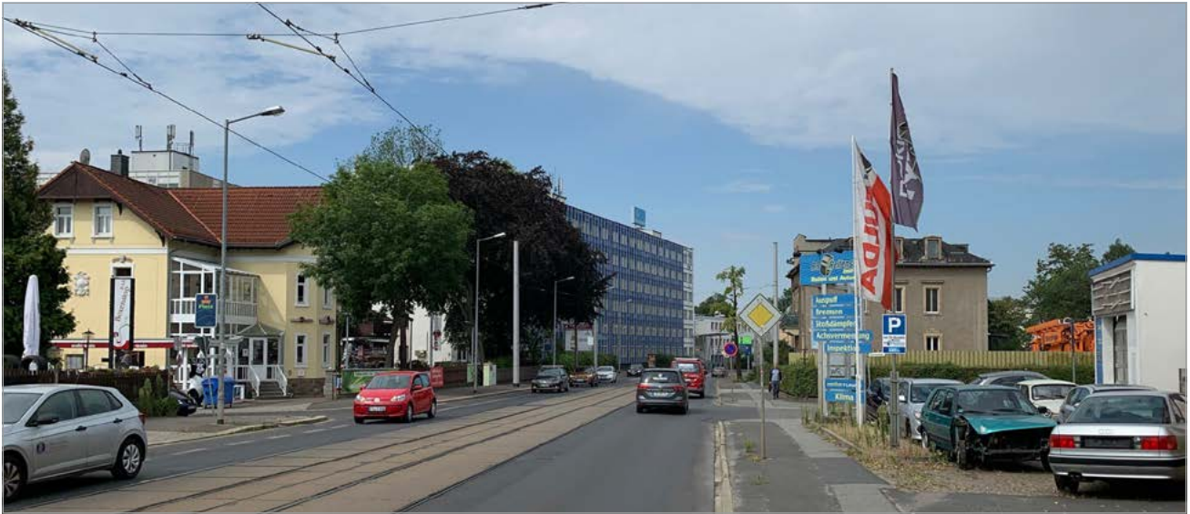
Meißner Straße, Blick Richtung Westen auf das 70er-Jahre-Bürohaus des ehem. VEB Kombinat Kraftwerksanlagenbau am Wasapark-Gelände. Für das Gelände ist eine Neubebauung vornehmlich mit Wohnungen projektiert.
